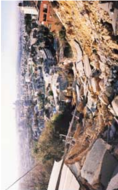
C2. カラーページ 東灘区岡本・ヘルマンハイイツ団地盛り土造成部からの崩壊・地すべり Landslide and Slope Collapse Due to House and Road Construction on Poorly Done Landfill on the Mountainside
