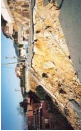
C2. カラーページ 東灘区岡本・ヘルマンハイイツ団地盛り土造成部からの崩壊・地すべり Landslide and Slope Collapse Due to House and Road Construction on Poorly Done Landfill on the Mountainside
