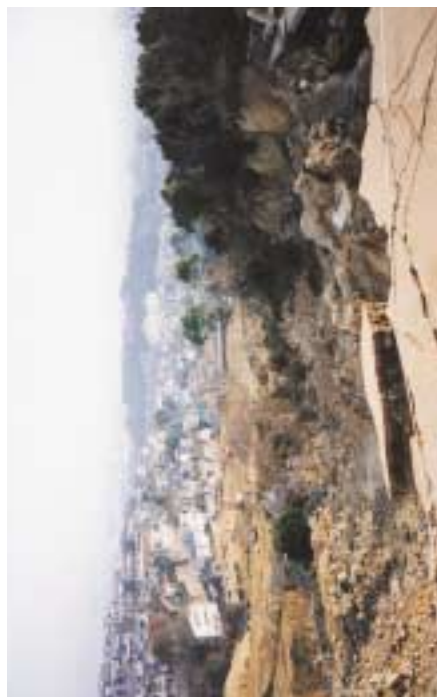
C1. カラーページ 西宮市百合ヶ丘市営浄水場の盛り土斜面からの崩壊・地すべり Landslide and Collapse of Badly-Done Landfill Beneath Water-Purification Plant Buildings
