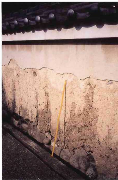
上賀茂神社付近の民家の土壁・メジャー1 m Mud Wall in Kamigamo, Kyoto, Japan
