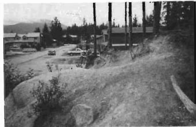
花崗岩の砂礫からなるモレーンの小丘群を平坦化して進む宅地
