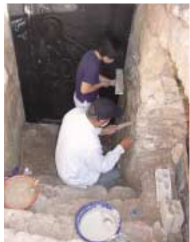
浮き上がっている壁面の落下を防止するためモルタルを充填する（階段東壁）
