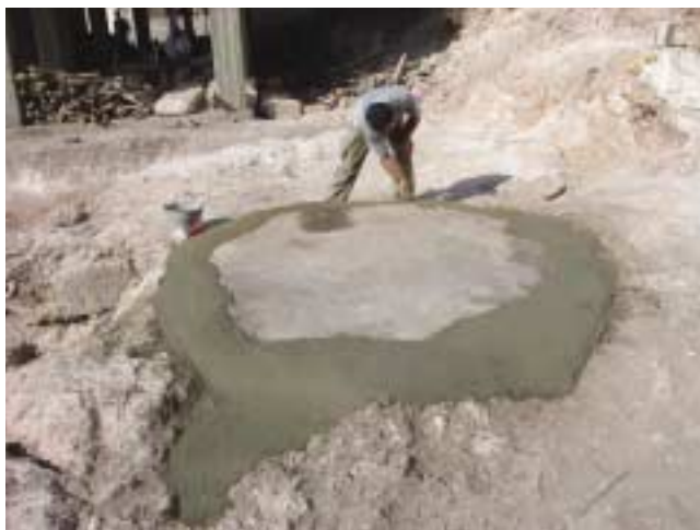
天井コンクリート蓋縁にモルタルを充填し雨水の流入を防止する
