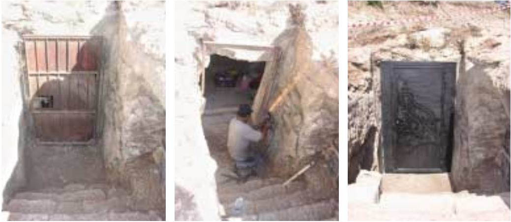
保護扉の交換(左：旧扉 中：旧扉の撤去 右：新扉)
