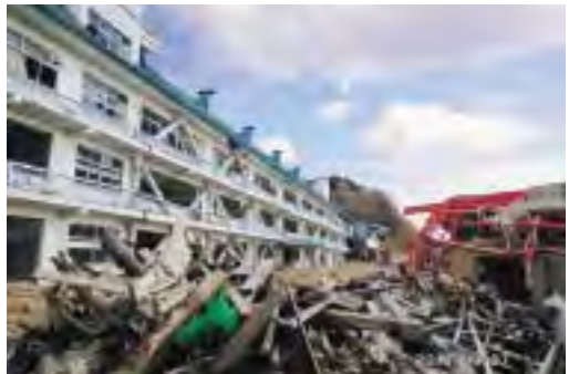
高田市役所の全景と内部の被害状況 3階まで水没
