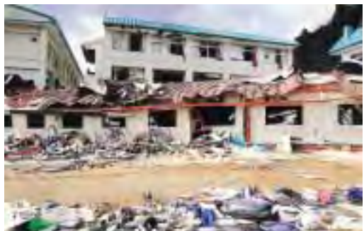
県立高田高等学校の被害状況 3階まで水没した
