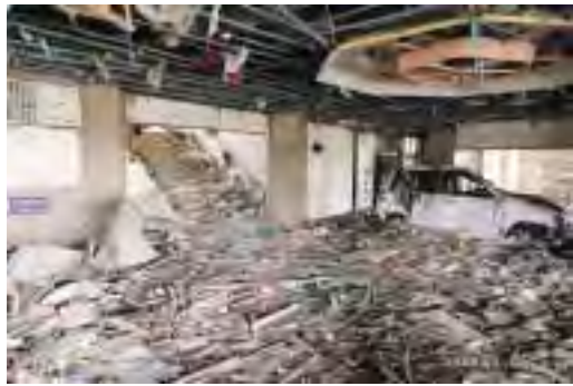
高田市役所の全景と内部の被害状況 3階まで水没
