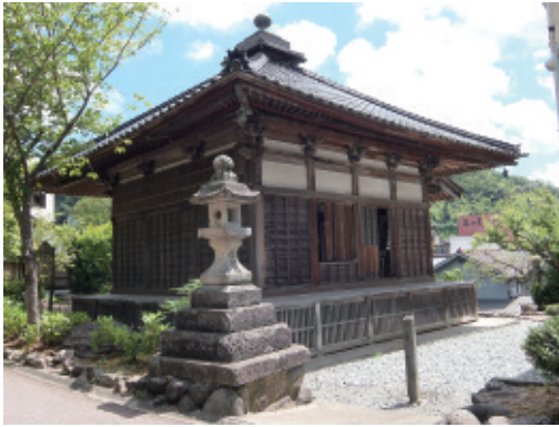
写真1 新温泉町湯区の薬師堂外観
