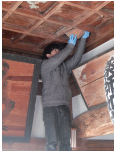
写真4 格天井板絵の取りはずし (2018年3月)
