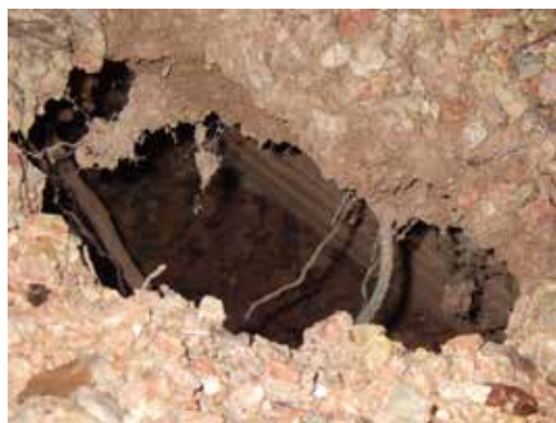
写真16 第1探信所跡の地下に遺る煉瓦壁
