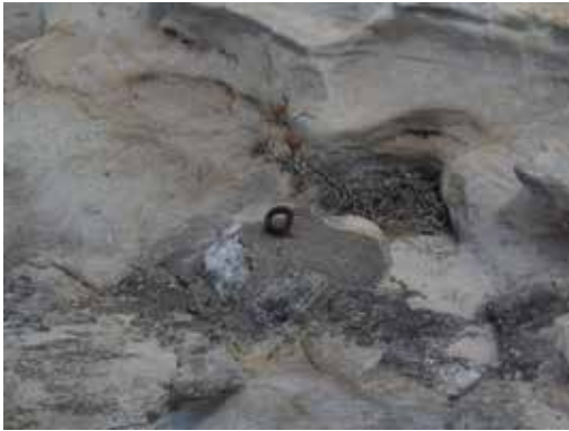
写真7 瀬戸崎 海底ケーブル支持金具
